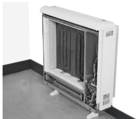
10.- Sitúe de nuevo las resistencias en su posición inicial, de forma vertical. Coloque la segunda fila de ladrillos con la cara lisa hacia el exterior. El piso inferior debe apoyar en las lengüetas de las resistencias.
